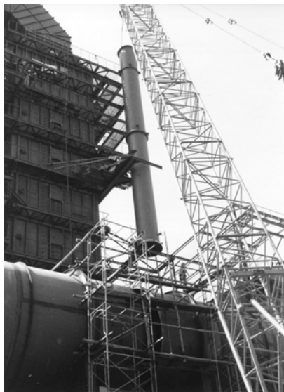
排煙脱硫装置配管工事 (福井県)
