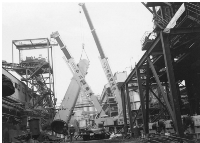
酸化搭据付工事(千葉県)
