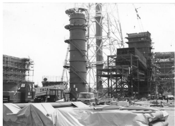
冷却塔据付工事 (福井県)
