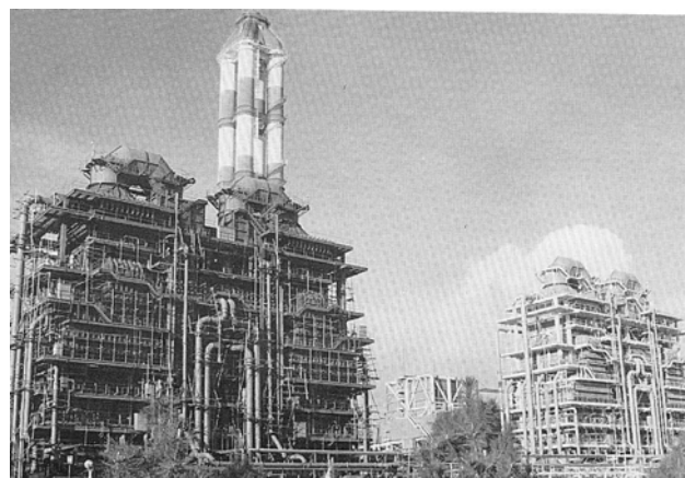
排煙脱硫装置配管工事(三重県)
