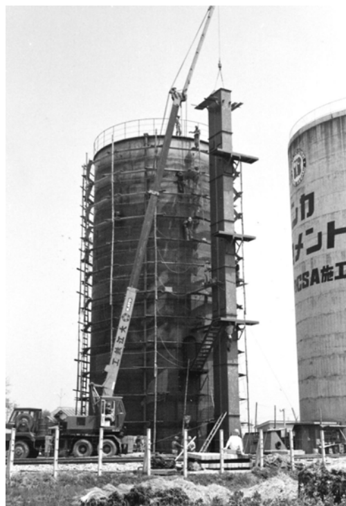
1,000・セメントサイロ製作据付(新潟県)
