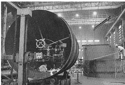
原子力発電所 補助エンジン地下燃料タンク製作(海上輸送)
