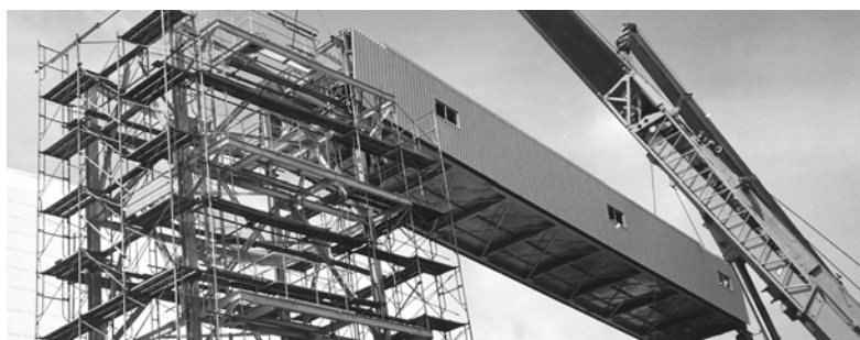
揚運炭設備据付工事
