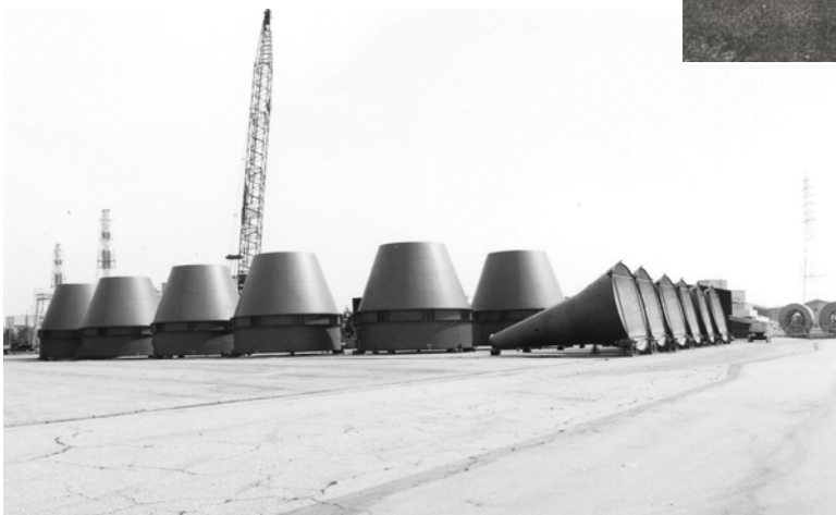
コールバンカー製作工事(海上輸送)
