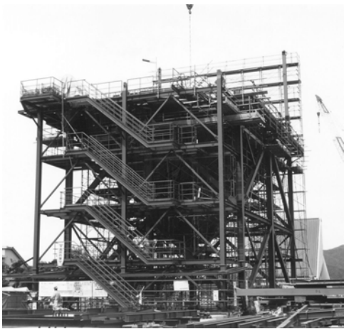
排ガス加熱器(熱回収器)製作据付工事
