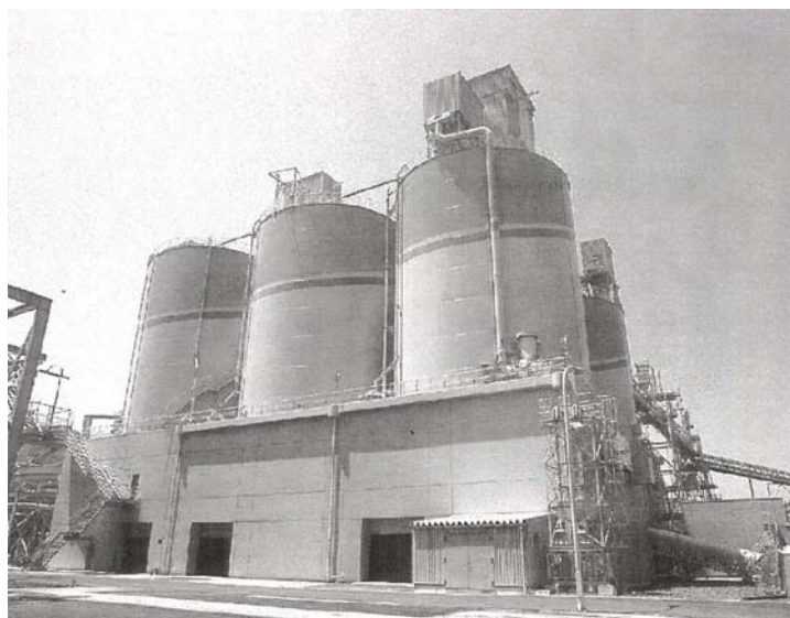
灰処理装置中継槽及び灰貯槽製作据付工事
