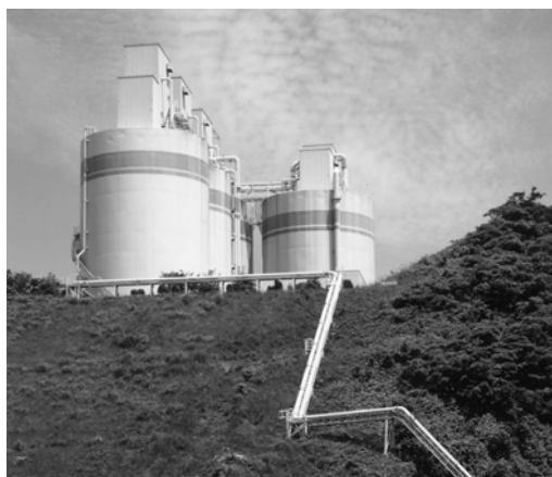
フライアッシュサイロ製作据付工事
